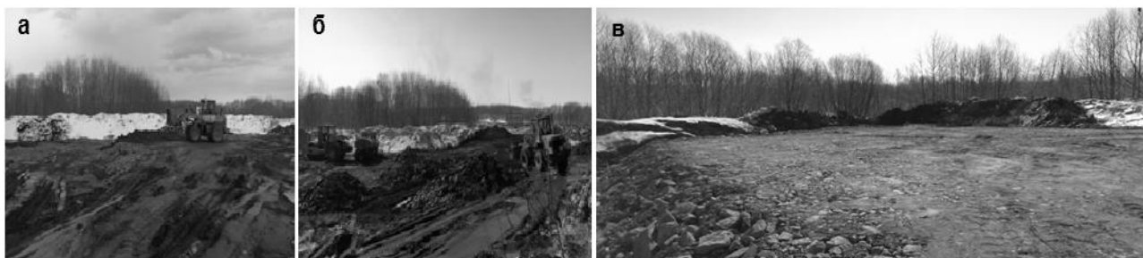
Рис. 5. Замена и уплотнение грунтов на исследуемой строительной площадке: а – замена верхнего 2 метрового слоя; б – засыпка и уплотнение щебнистого грунта с «Петровского» карьера; в – подготовленная площадка.
