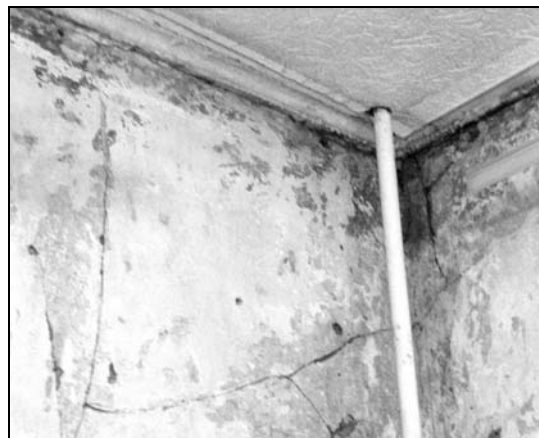
Рис. 6. Трещины в штукатурке стены, в стыке стен и потолка
