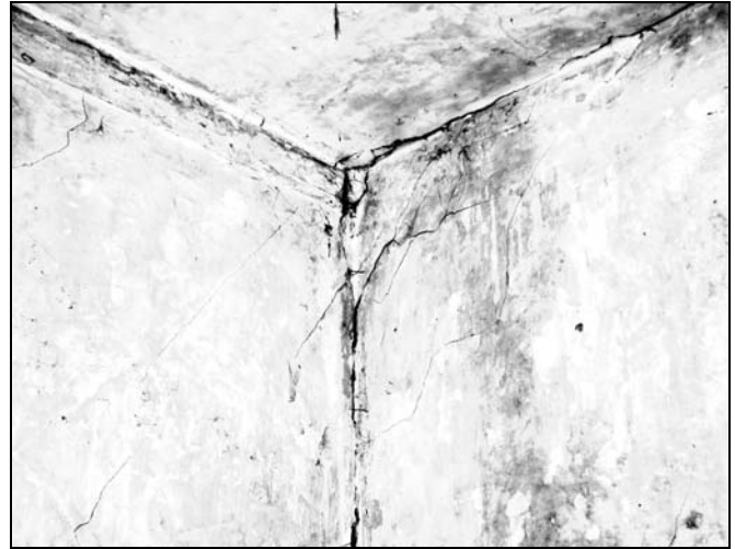
Рис. 5. Трещины в стыке стен и потолка
