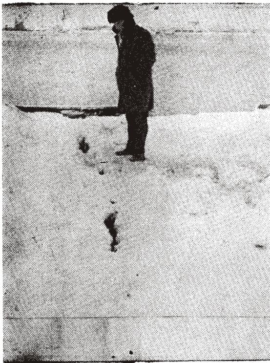
Рис. 5. Трешины в грунте у причала ЛПП
