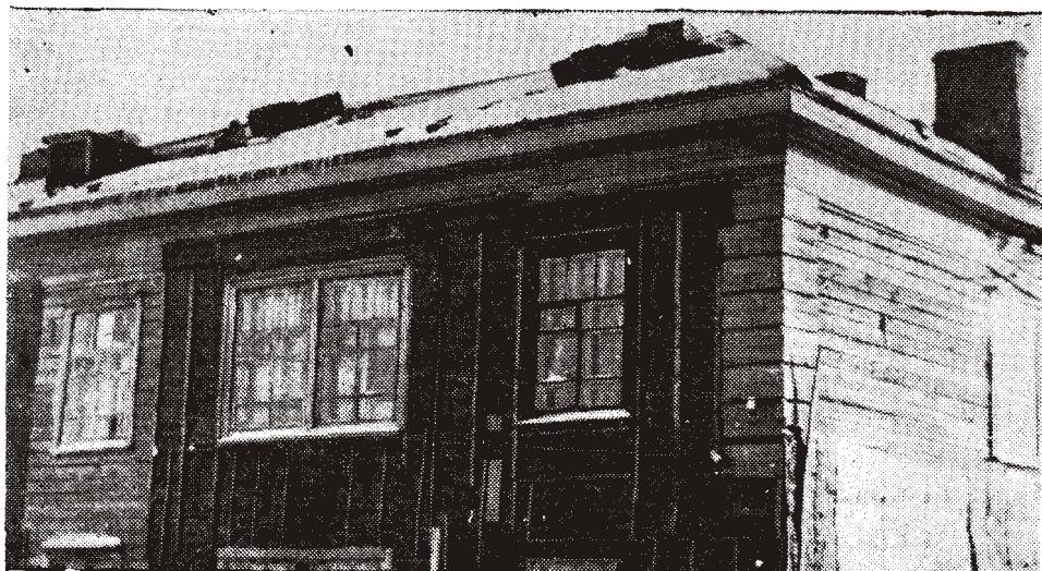
Рис. 2. Падение большинства труб, двухэтажный деревянный дом (Усть-Камчатск).
