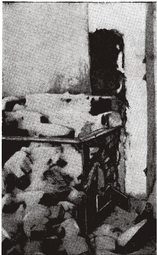
Рис. 1. Развалившаяся топка печи на втором этаже старого рубленого дома. Здание после землетрясения стало непригодным для жилья (Усть-Камчатск).
